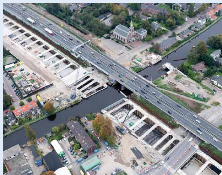
In het voorjaar van 2012 rijdt het verkeer over de A4 in de eerste verdiepte aangelegde bak. Met 2 x 3 rijstroken (naar Den Haag en naar Amsterdam) en 80 kilometer per uur. (Foto: Joop van Houdt Luchtfotografie)
